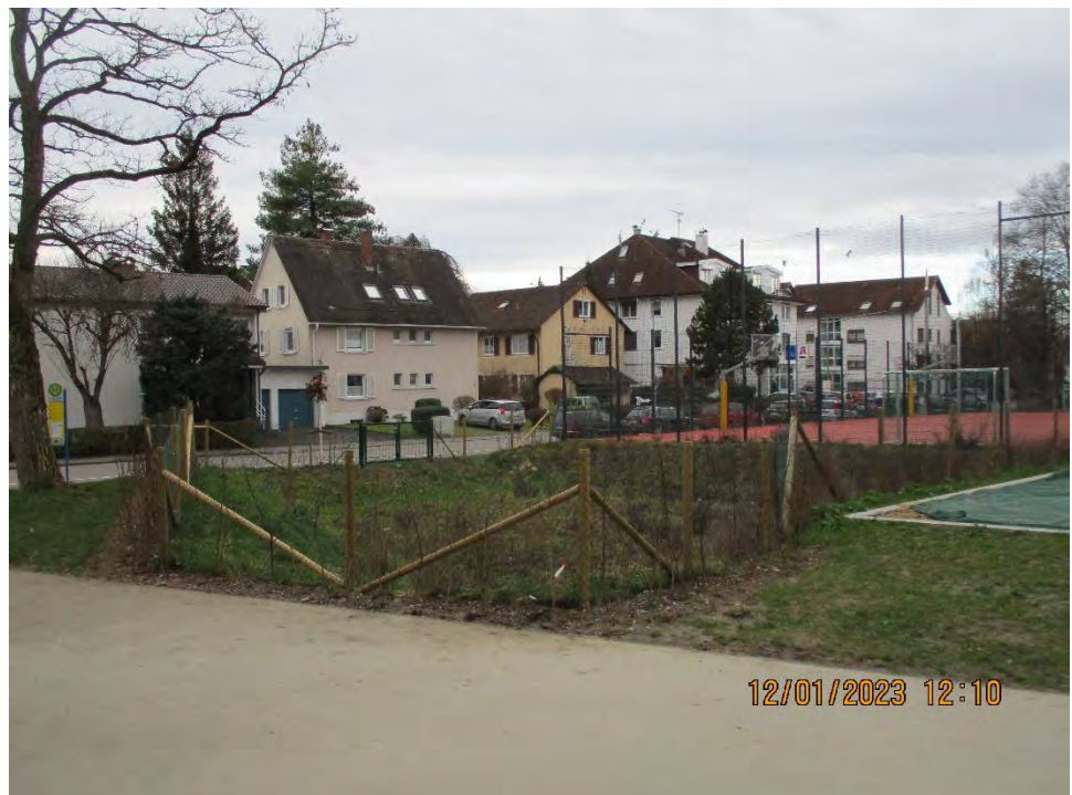
Abb. 5: Naturnah gestaltetes Retentionsbecken am zentralen Südrand des Plangebietes
