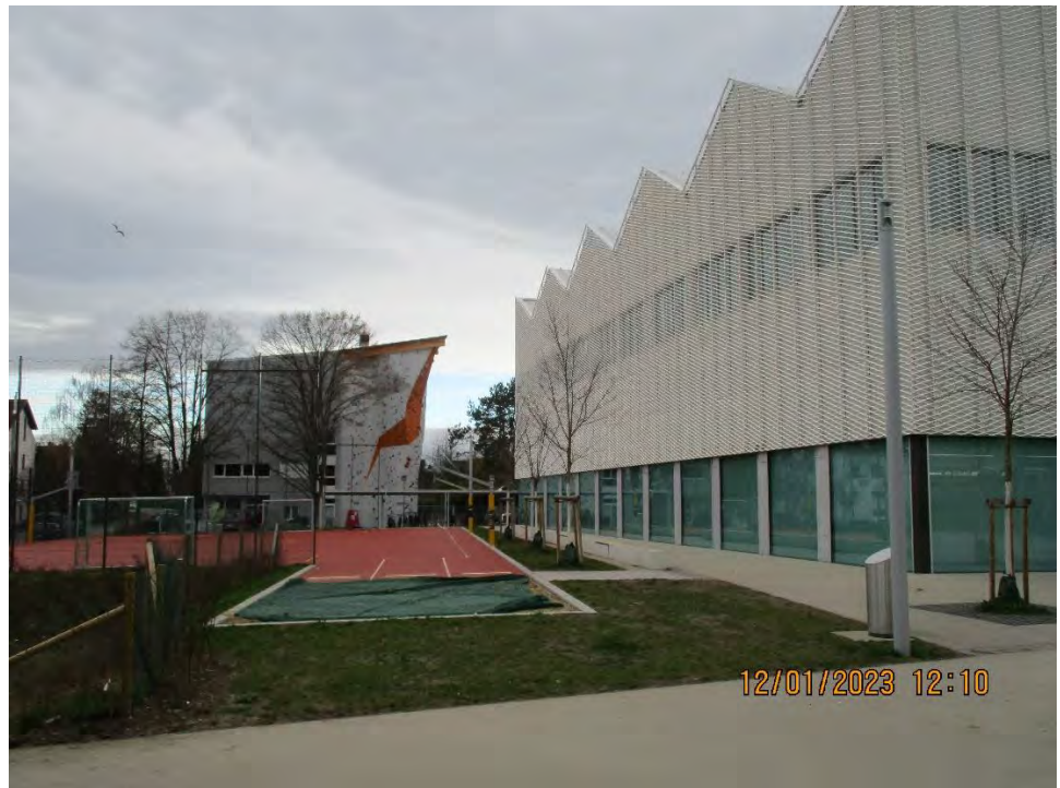
Abb. 6: Blick auf durchgeführte Baumpflanzungen an der neu erbauten Sporthalle zur Erhaltung einer guten Durchgrünung des Plangebietes
