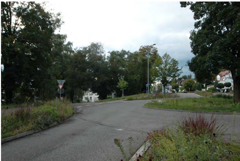
Abb. 10: Kreisverkehr an der Nußdorfer Straße mit Einfahrt in das Plangebiet
