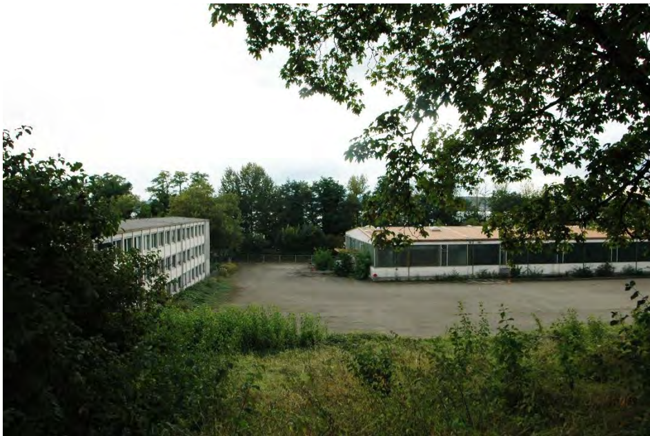
Abb. 12: Östlicher Teil des Plangebietes mit Lagerhalle und asphaltierten Flächen, links die Bebauung des benachbarten Gewerbeareals (ehem. Askania-Werke)
