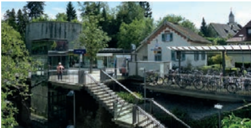
Bahnhof Überlingen Treppenabgang zu den Bahngleisen - Fahrradunterstellplätze im westlichen Bereich
