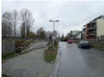
Bahnstrecke als räumliche Barriere Bereich Schilfweg
