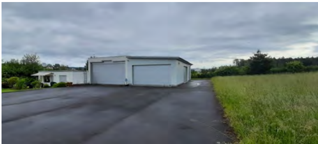
Abb. 7: Blick auf ein sich im zentralen Bereich des Plangebietes befindliches Gebäude, Aufnahme vom 25.05.2022.
