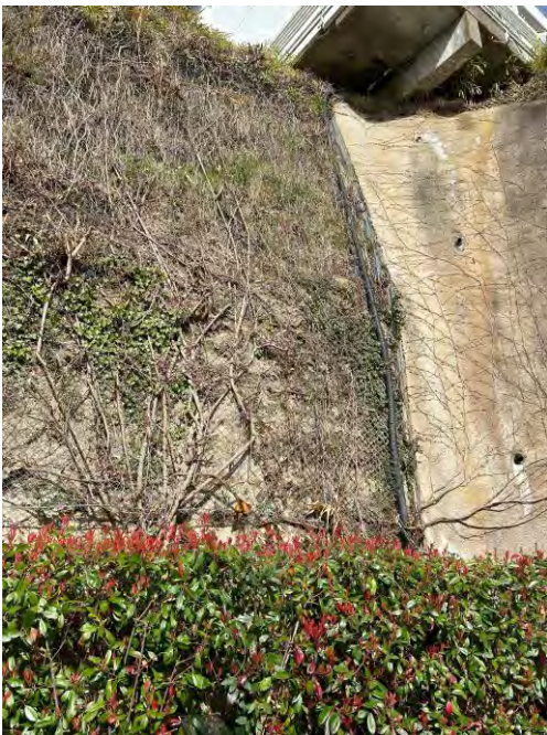
Abbildung 17: freigelegter, gesicherter Molassefelsen im gepflegten Zustand im Frühjahr. Der Felsen ist in der Vegetationszeit stark überwuchert und bietet keine besonnten Bereiche.
