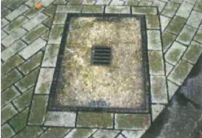
Abbildung 5: Umpflasterung von Einbauten
