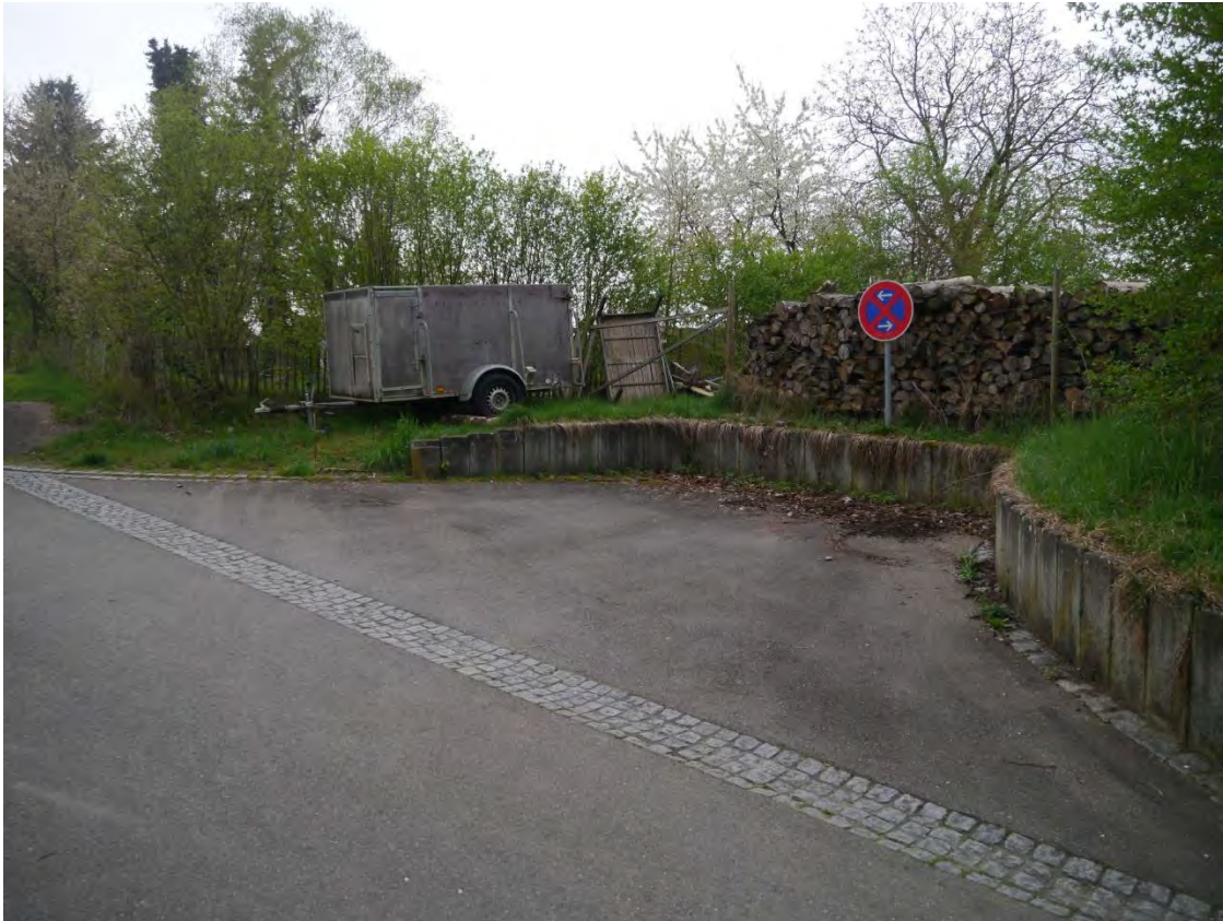
Südliches Ende des asphaltierten Bereichs der Hohrainstraße, Wendehammer mit Stützmauer.
