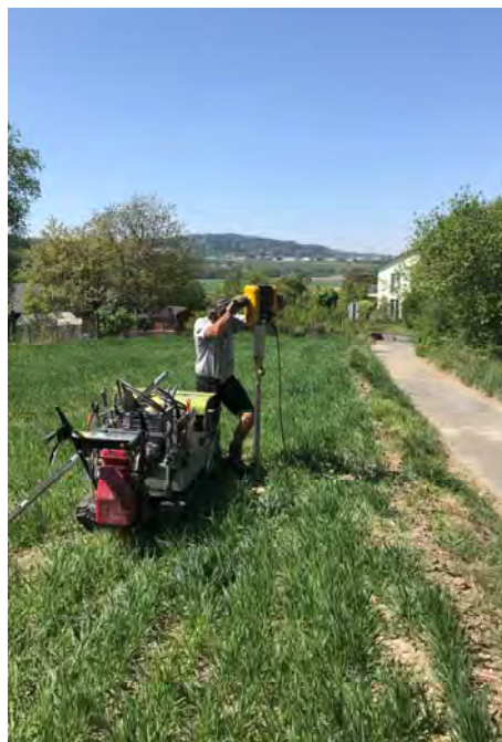
Techniker bei der Rammkernsondierung BS 4.
