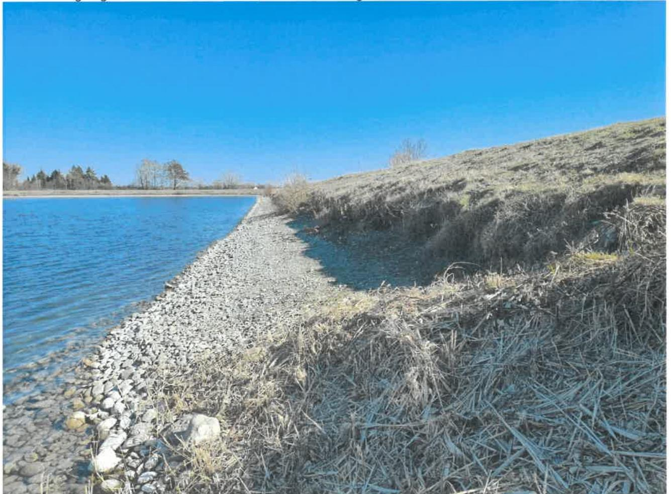
→ wir bitten Sie um Genehmigung zur Wiederherstellung der wasserseitigen Dammf lächen durch Aufbringung von Erdmaterial
