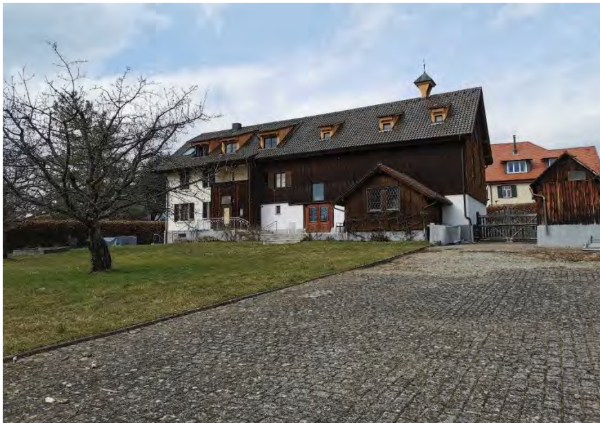
Abbildung 4: Bestandsgebäude, Freifläche und Stellplatzfläche Bestand, rückwärtiger Bereich
