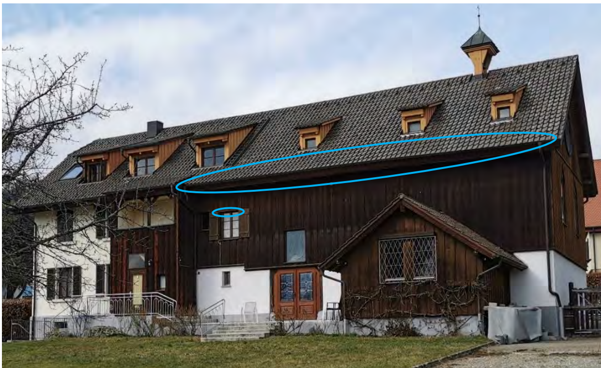
Abb. 14: Südseite des Kirchengebäudes und zu erhaltene Bereiche von Einschluflmöglichkeiten in blau
