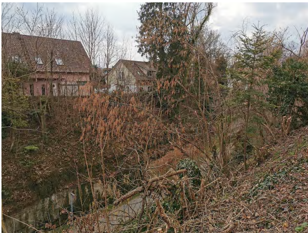
Abbildung 13: Scheerengraben, Blick nach Südwesten (06.03.2023)
