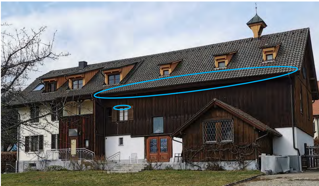
Abbildung 8: Südseite des Kirchengebäudes und zu erhaltene Bereiche von Einschupfmöglichkeiten in blau
