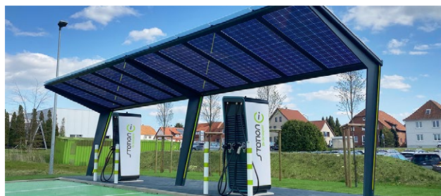
Abbildung 4: Solarer Mobilityhub für Parkplätze und E-Autos: E-Schnellladesäulen mit PV-Strom optional mit Informationsdisplay für Bürger*innen, Paketstation, Getränkeautomat, LED-Beleuchtung, Sitzbank, W-LAN Hotspot, usw. – je nach Bedarf.
