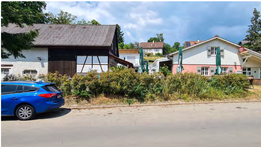
Bauernhaus und bestehendes Restaurant
