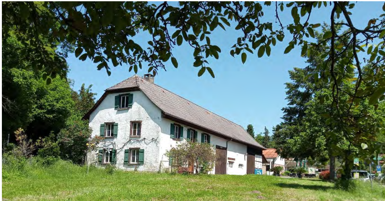
Abb. 1: Gebäude Goldbach 31, Blick aus Süden
