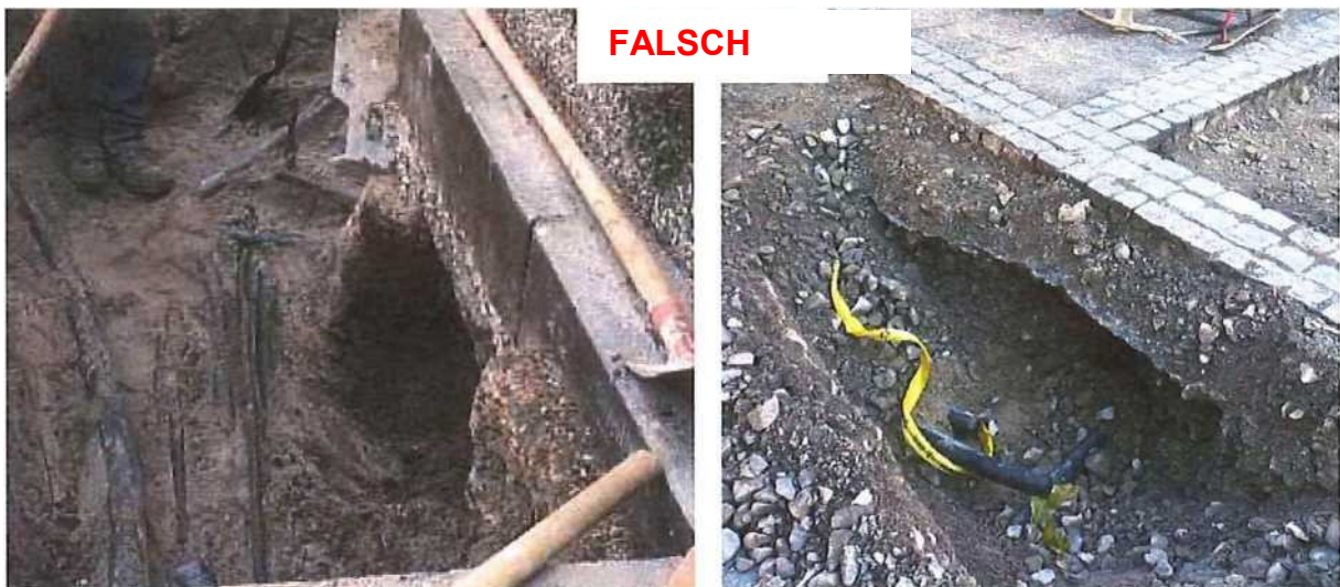
Abbildung 6: Negativbeispiele Unterhöhung von Randeinfassungen
