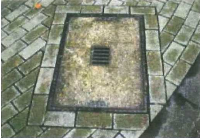
Abbildung 5: Umpflasterung von Einbauten
