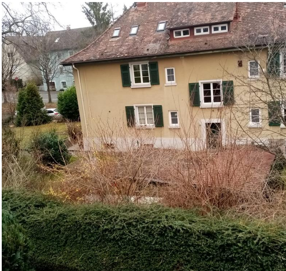
Abbildung 8: Bestandsgebäude rückwertiger Bereich
