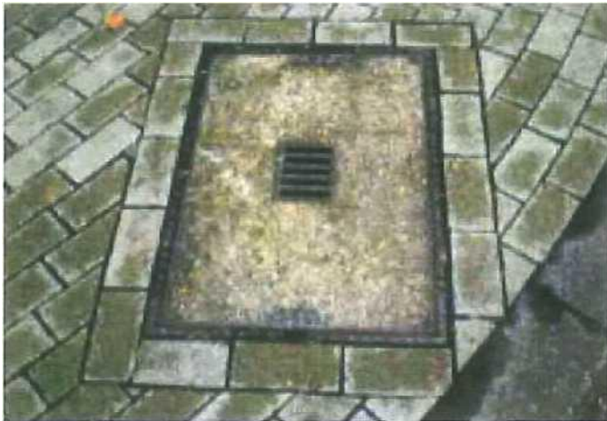
Abbildung 5: Umpflasterung von Einbauten
