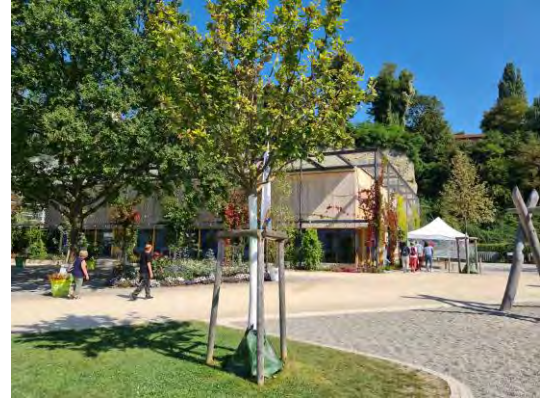
Abbildung 11: Abbildung Südseite Gastronomiegebäude
