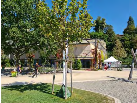
Abbildung 10: Abbildung Südseite Gastronomiegebäude
