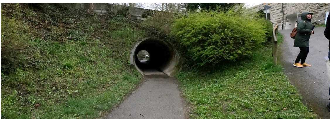
Abbildung 44: Durchgangstunnel unter der Aufkircher Straße
