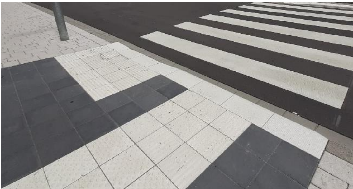
Abbildung 13: Beispiel für eine differenzierte Bordhöhe an einem Fußgängerüberweg
