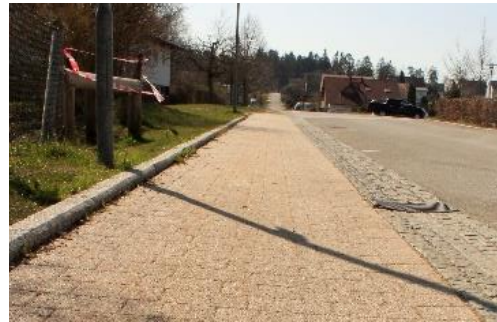
Abbildung 14: Beispiel für klare Leitkanten an einem Gehweg
