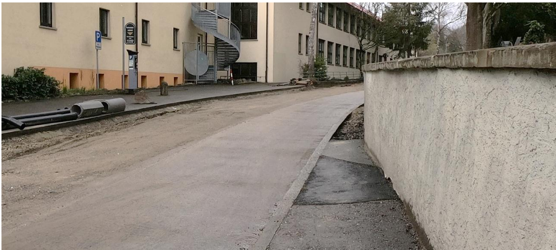
Abbildung 64: schmaler Gehweg mit schlechter Einsicht auf die Straße
