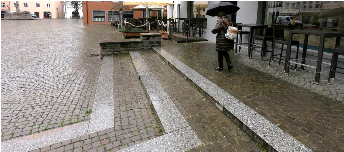
Abbildung 40: Eingeschränkter barrierefreier Zugang zum Platz auf der Hofstatt
