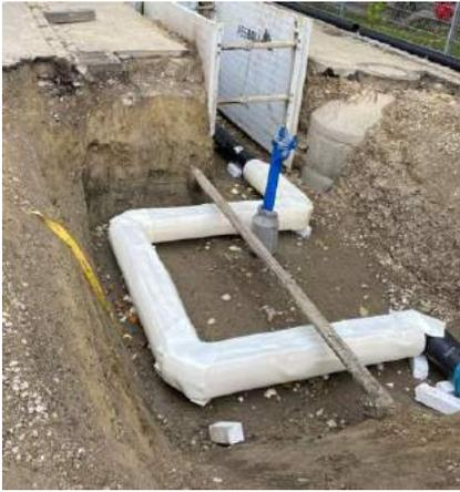
Abbildung 119: NW-Leitung (DN 65 KMR-Doppelrohr) mit U-Dehner und Polsterung (eigene Darstellung)
