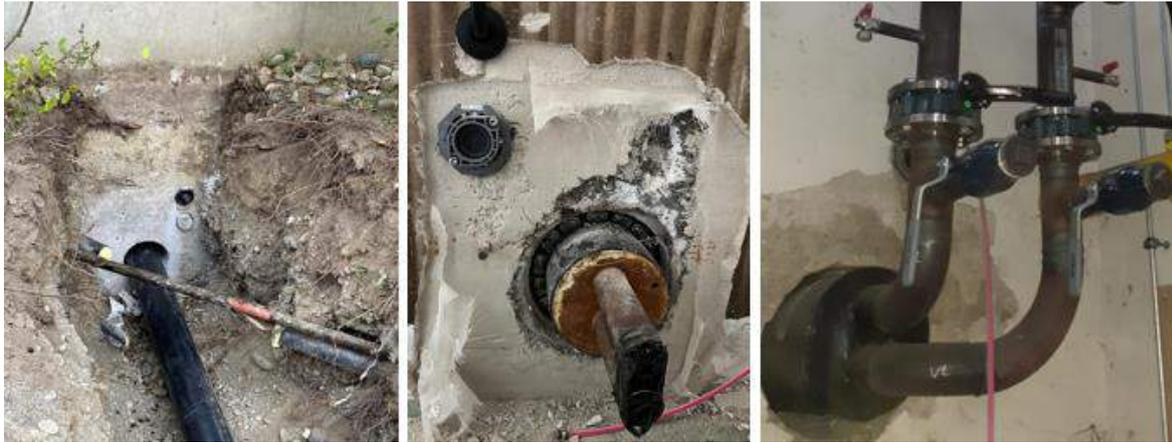
Abbildung 122: Hauseinführung (DN 50 KMR-Doppelrohr) (eigene Darstellung)
