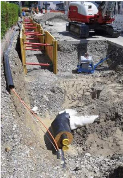
Abbildung 120: NW-Leitung (DN 125 KMR-Doppelrohr) U-Dehner (eigene Darstellung)
