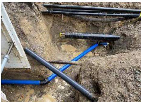
Abbildung 118: NW-Leitung (DN 65 KMR-Doppelrohr) und andere Gewerke (eigene Darstellung)
