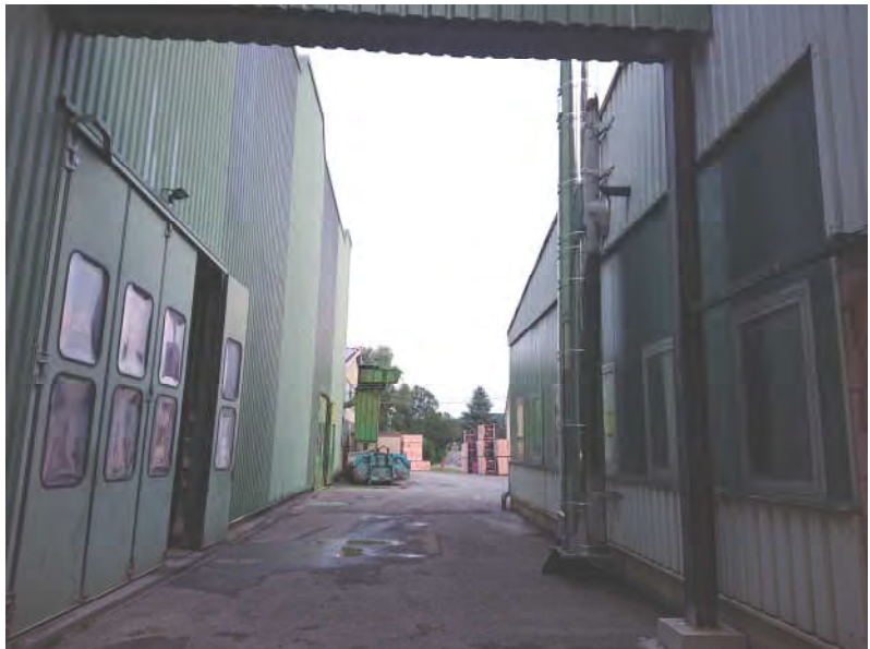
Abbildung 5: Fassade der Produktionshalle
