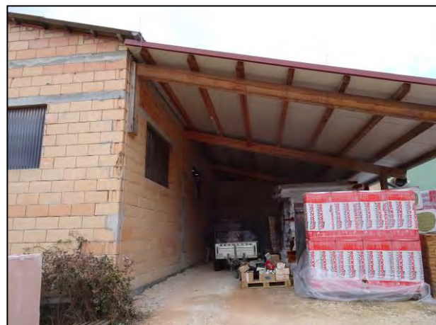
Abb. 6: Anbau am Ostende der Halle.
