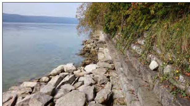
Abbildung 8: befestigte und bepflanzte Uferböschung entlang des Überlinger Seeufers an der Bahnhofstraße
