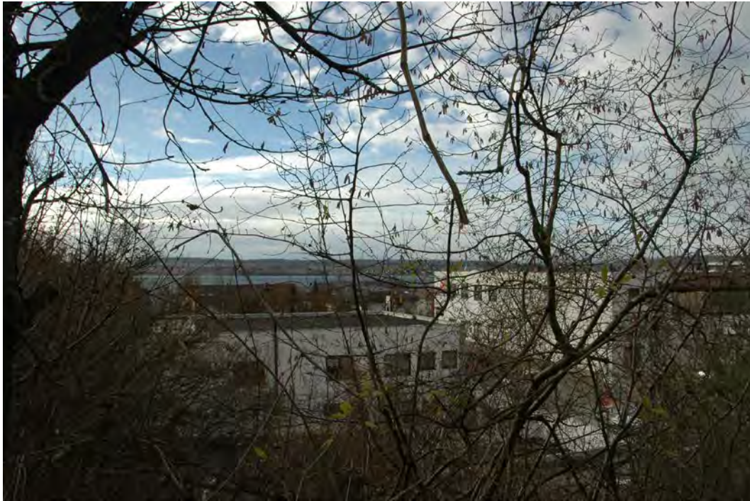
Blick von Nordosten auf das aufzustockende Gebäude
