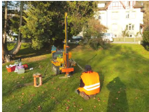
Abb.5: Schwere Rammsondierung am Ansatzpunkt DPH 1/13
