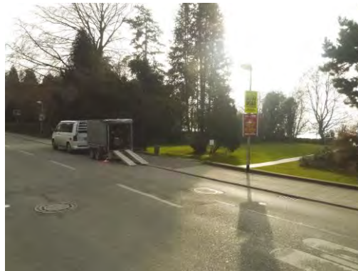
Abb.2: Anlieferung Sondierfahrzeug, Abschnitt C-Pflanzenhaus
