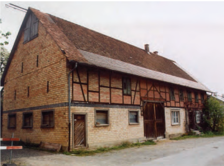
Alter Bauernhof in der Strasse "Zum Laugele"
