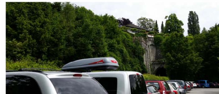
Parkplatz der Therme mit Molassefelskante und Tunnelportal im Norden
