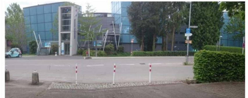
Thermekomplex im Süden des Plangebiets, die Blickbeziehung zum Bodensee wird verdeckt.
