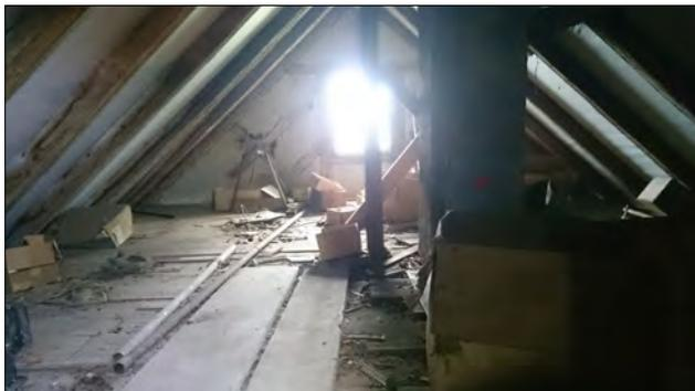
Abbildung 8: Dachboden über dem Wohnhaus im Hauptgebäude. Durch Fenster relativ hell, außerdem Abdichtung mit Folie zwischen Dachziegeln und Gebälk.
