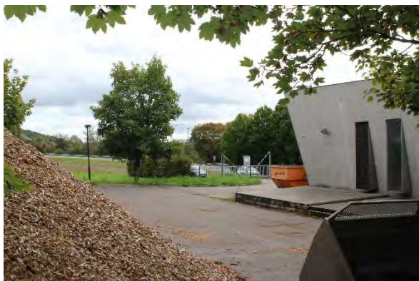
Bestand im Bereich der Hackschnitzelanlage mit Gebäuden und versiegelten Flächen.
