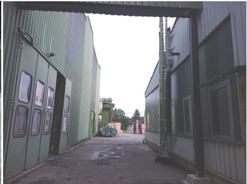
Abbildung 5: Fassade der Produktionshalle
