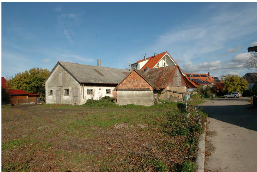
Blick von Westen auf das Plangebiet
