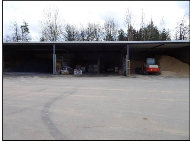
Abb. 4: Blick von Norden auf die entlang der Südgrenze gelegenen überdachten Lagerbereiche.
