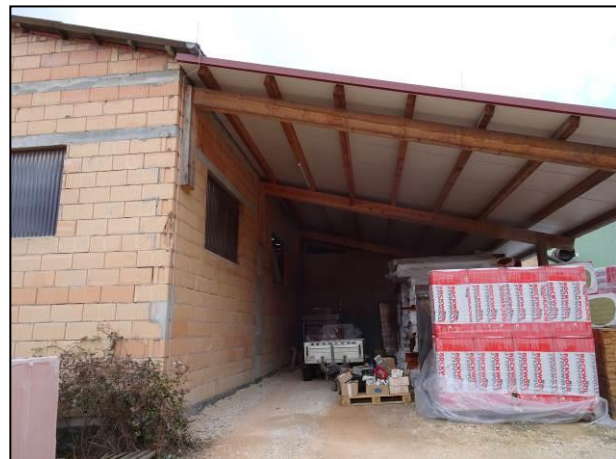
Abb. 6: Anbau am Ostende der Halle.
