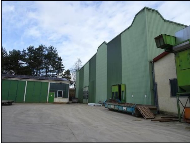
Abb. 3: Blick von Süden in den Innenhof zwischen Verwaltungsgebäuden und der Produktionshalle (rechts im Bild).
