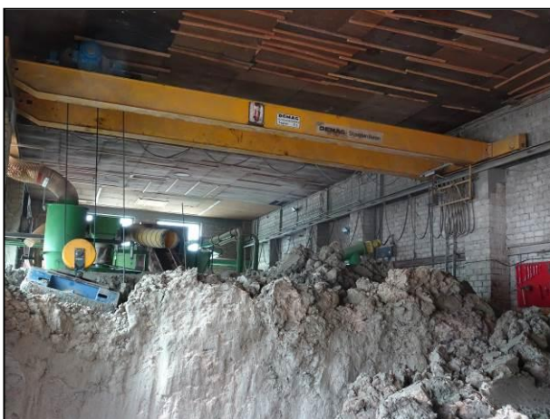
Abb. 7: Blick ins Innere der Produktionshalle. Gut zu sehen die provisorische Holzkonstruktion des Zwischenbodens.
