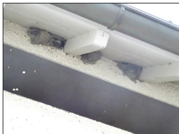
Abb. 8: Mehlschwalbennester unter einem der Dachvorsprünge.
