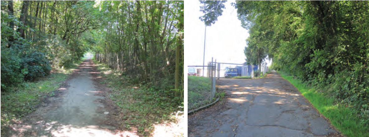
Foto 4+5: Der geteerte Waldweg am östlichen Waldrand (angrenzend an die Lagerflächen der Firma PUREN) stellt ein wichtiger Forst- und Verbindungsweg zwischen Adelshofen und der Waldorfschule/ dem Haus Rengold dar.
