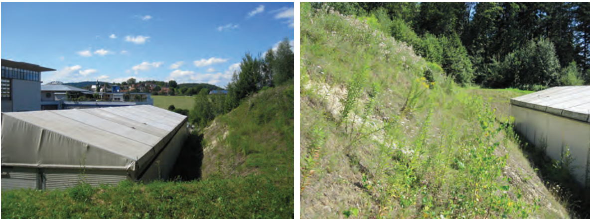
Foto 6+7: Die südwestexponierte Böschung auf dem Gelände der Firma Allweier besitzt z.T. offene Bodenstellen, die einen wichtigen Lebensraum für trocken- und wärmeliebende Pflanzen- und Tierarten (Zauneidechse) darstellen.
