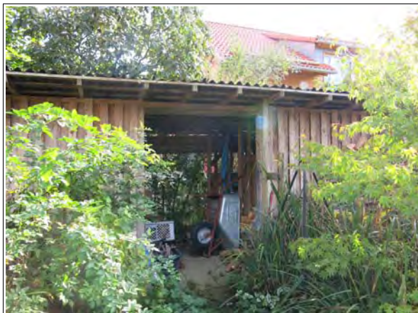
Abbildung 6: kleiner Geräteschuppen im südöstlichen Plangebiet
