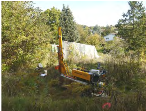
Abb.6: Schwere Rammsondierung am Ansatzpunkt DPH 2/13
