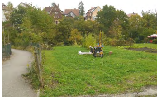
Abb.11: Rammkernsondierung am Ansatzpunkt RKS 5/13
