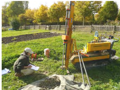
Abb.12: Schwere Rammsondierung am Ansatzpunkt DPH 4/13
