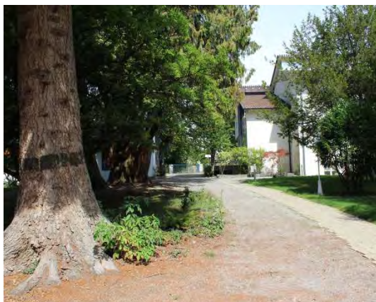
Blick auf den westlichen Teil des nördlichen Gebäudes (Gebäude 17)
