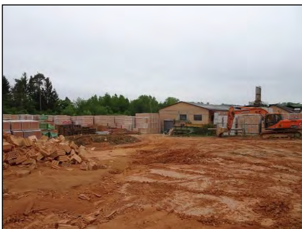
Abb. 13: Blick von der Ziegelbruchlagerfläche Richtung Gebäude im Südwesten.
