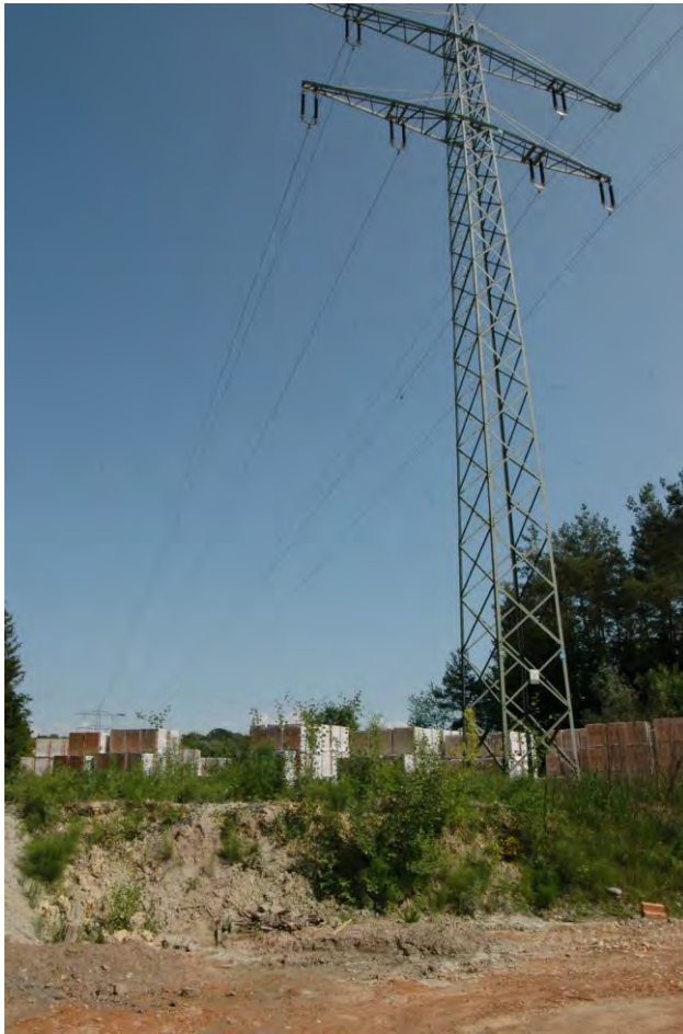
Mast der 110-kV-Freileitung im östlichen Bereich des Betriebsareals
