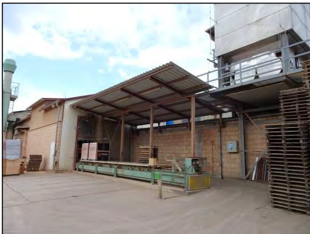
Abb. 5: Anbau im Südosten der Halle.
