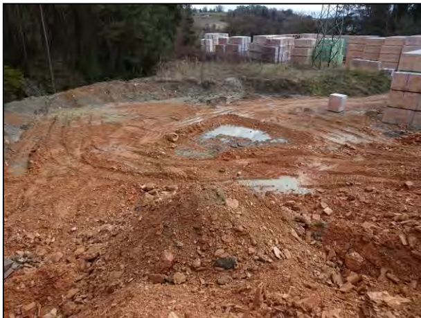
Abb. 17: Pfützenbildung innerhalb des Lagerbereichs.
