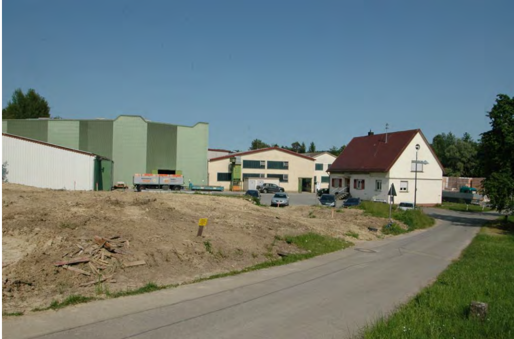
Blick von Nordwesten auf das Ziegelei-Areal, rechts das zum Abbruch vorgesehene eingeschossige Bürogebäude
