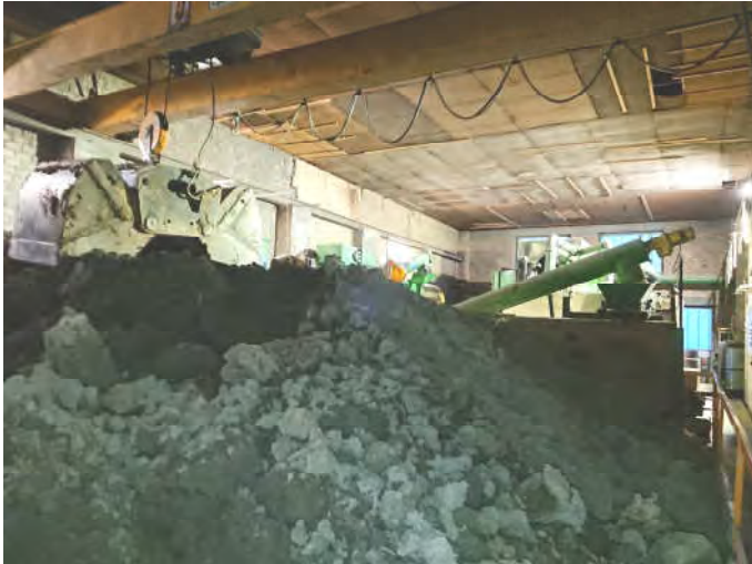
Abbildung 2: Kran an Decke im Rohstofflager
