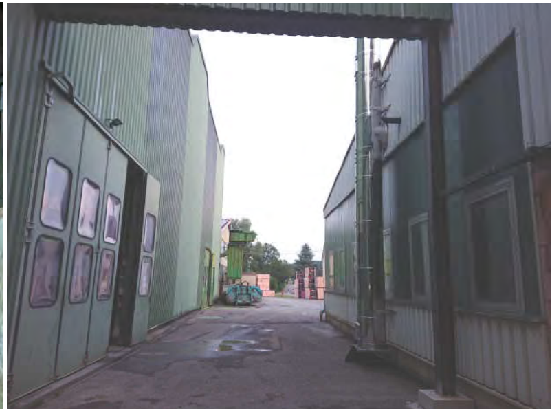
Abbildung 5: Fassade der Produktionshalle
